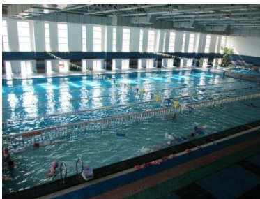
50Mの競泳用の室内温水プールを完備。
